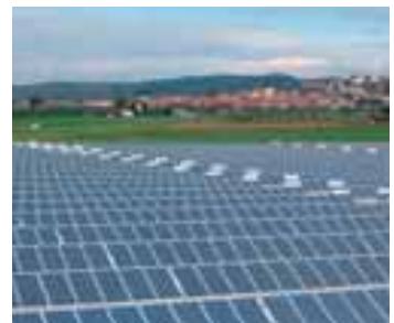
Pequeña central eléctrica
