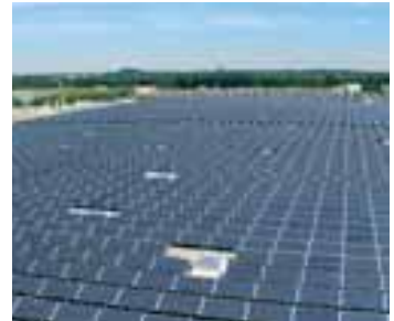
Pequeña central eléctrica
